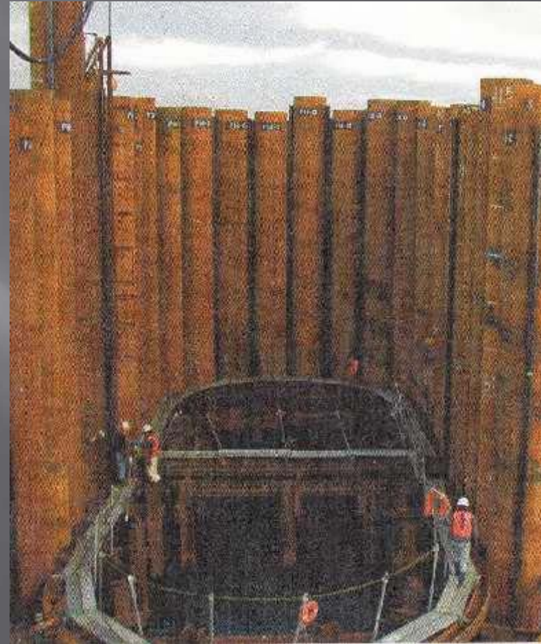
Dựng kết cấu tường cọc ống thép
