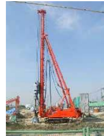
Máy đóng cọc
