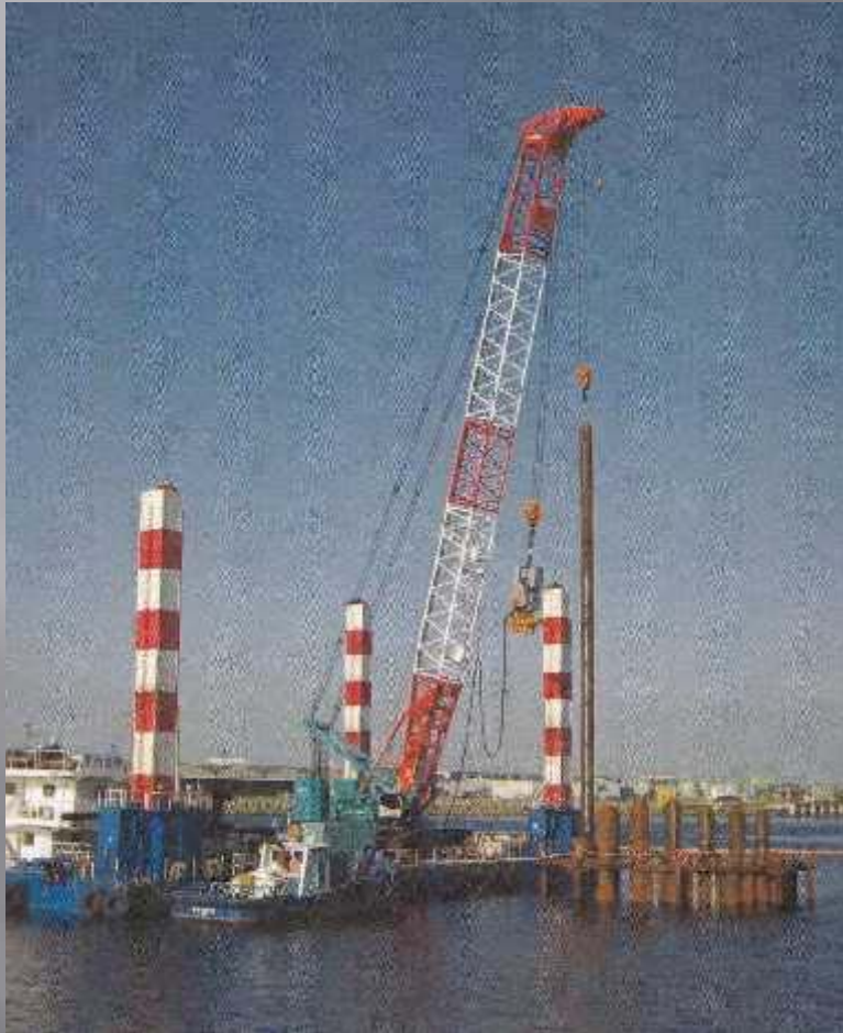
Dựng cọc ống thép trên sông
